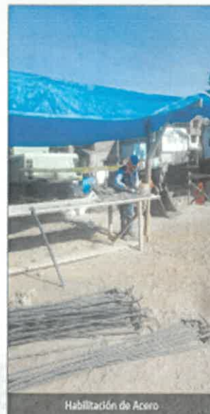
Habilitación de Acero
